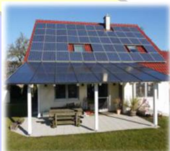
Installazione su tetto
